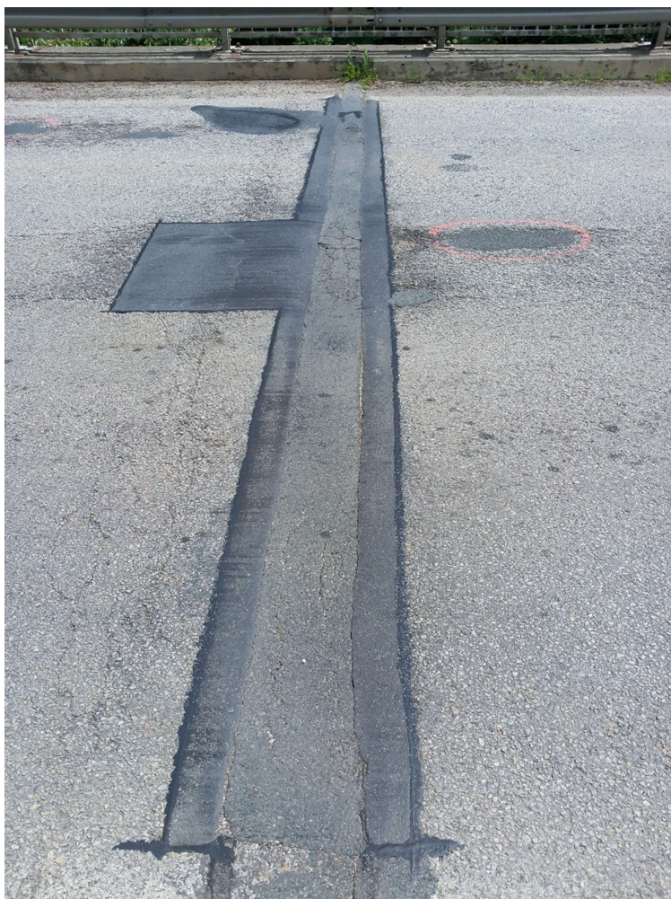
Obrázek 4 - Stávající MDZ na OP2
