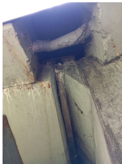
Obrázek 3 - Kabel VO vedený římsou v místě MDZ
